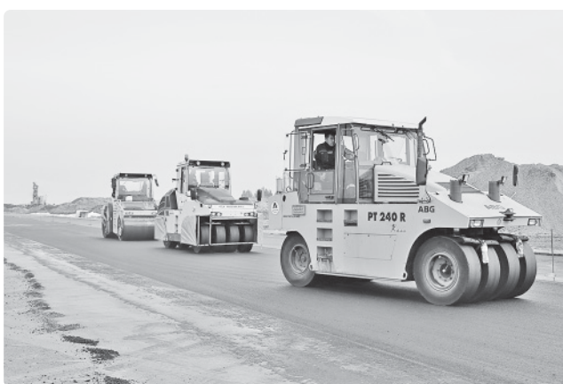
Строительство взлётно-посадочной полосы
